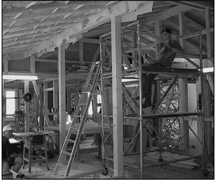
Kantine in aanbouw
