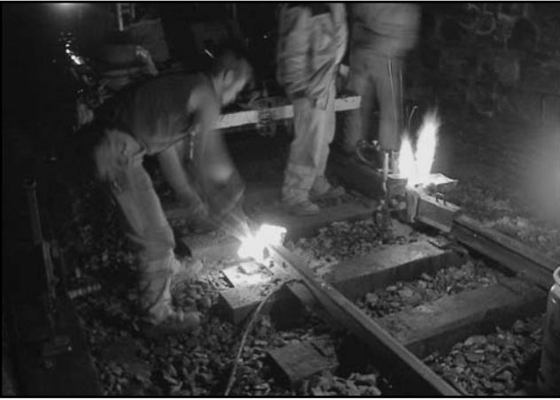
Rails lassen in de Scheiteltunnel
