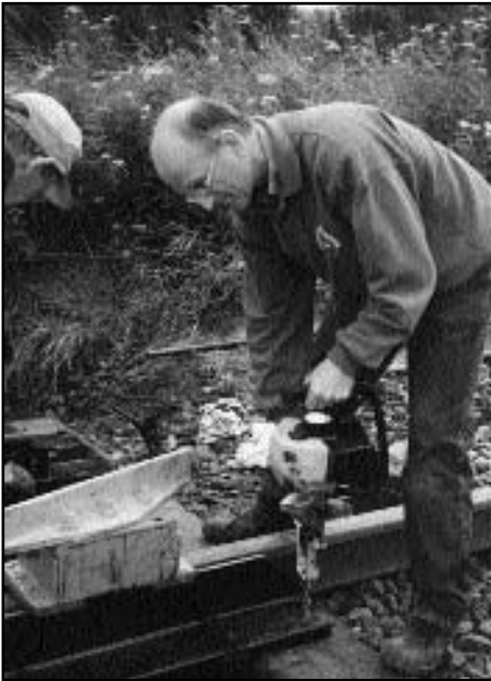
Paul bij het plaatsen van een ontsporingsblok.
